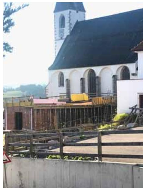
Die Größe und Höhe des Gebäudes verändert sich nicht mehr. Innenwände werden bereits gemauert, nachdem die Steher vom Deckenbetonieren entfernt wurden.
